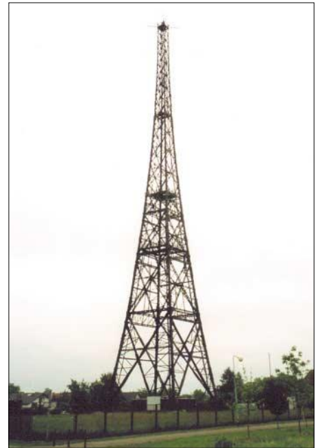
Schon weithin sichtbar: der hölzerne Sendeturm mit einer Höhe von 110 m
